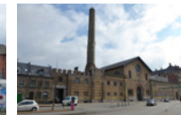
Østre Elektricitetsværk Østerbro, 1902, Ludvig Fenger Parts of it in use as office spaces (HOFOR)
