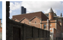
Vestre Elektricitetsværk København K, 1898, Ludvig Fenger In use as a cooling central
