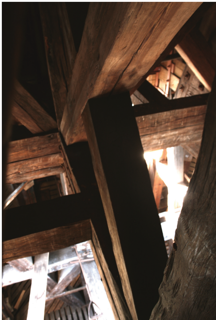
Massivtræskonstruktion i Sankt Petri Kirkes klokketårn
