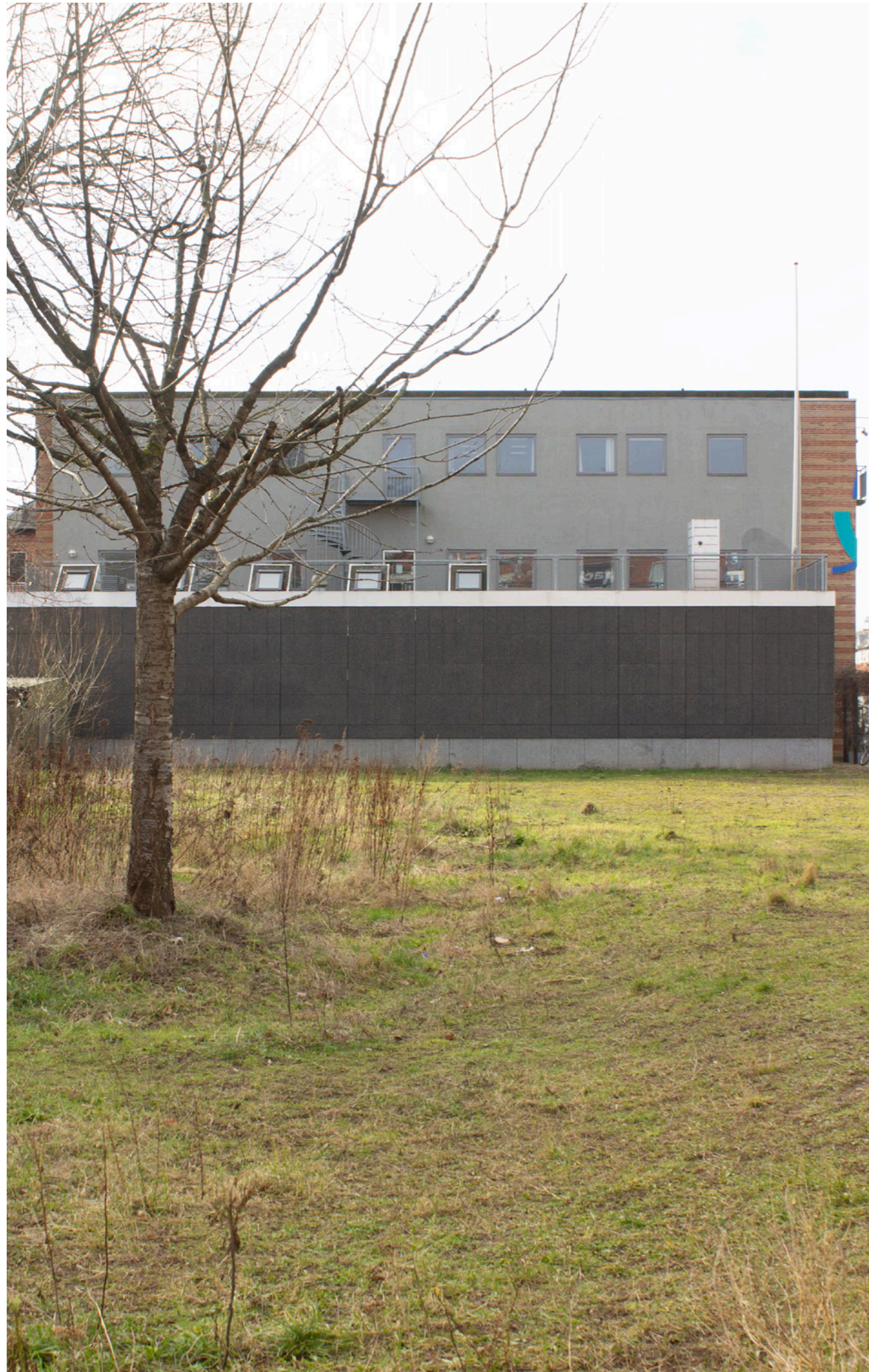
12 Eget foto. Kig fra offentligt område mod bygningens nordøstlige facade.
