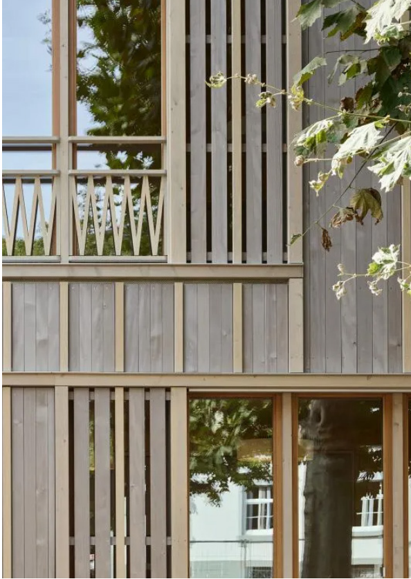
Doppelkindergarten Sissach Kast Kaepeli Architects
