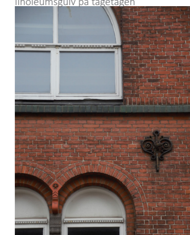
Udskiftede vinduer på øst facaden
