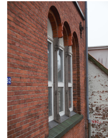
Eksis. granitsøjler og sålbænk af glasserede tegl samt de udskiftede tophængte 70'ers vinduer.
