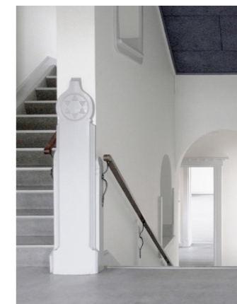
Trædetaljeringen med stjernemotiver placeret på søjle mellem trappe op- og nedgang, samt gelænder vægmonteringer og gennemgående lysninger i trappevæggen
