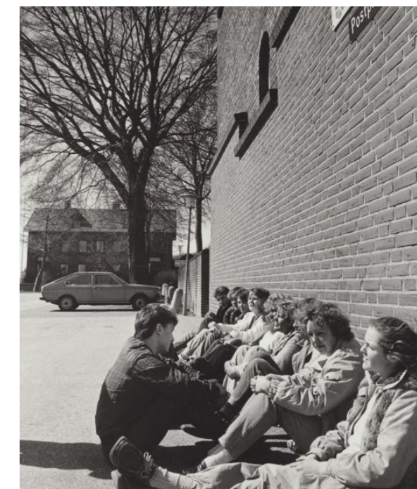
Arkivfoto fra 1985, her ses Postparkeringen som i dag med skærmmur og ny skalmur/bundstykke på Hjørring Teknisk Skoles sydlige facade
