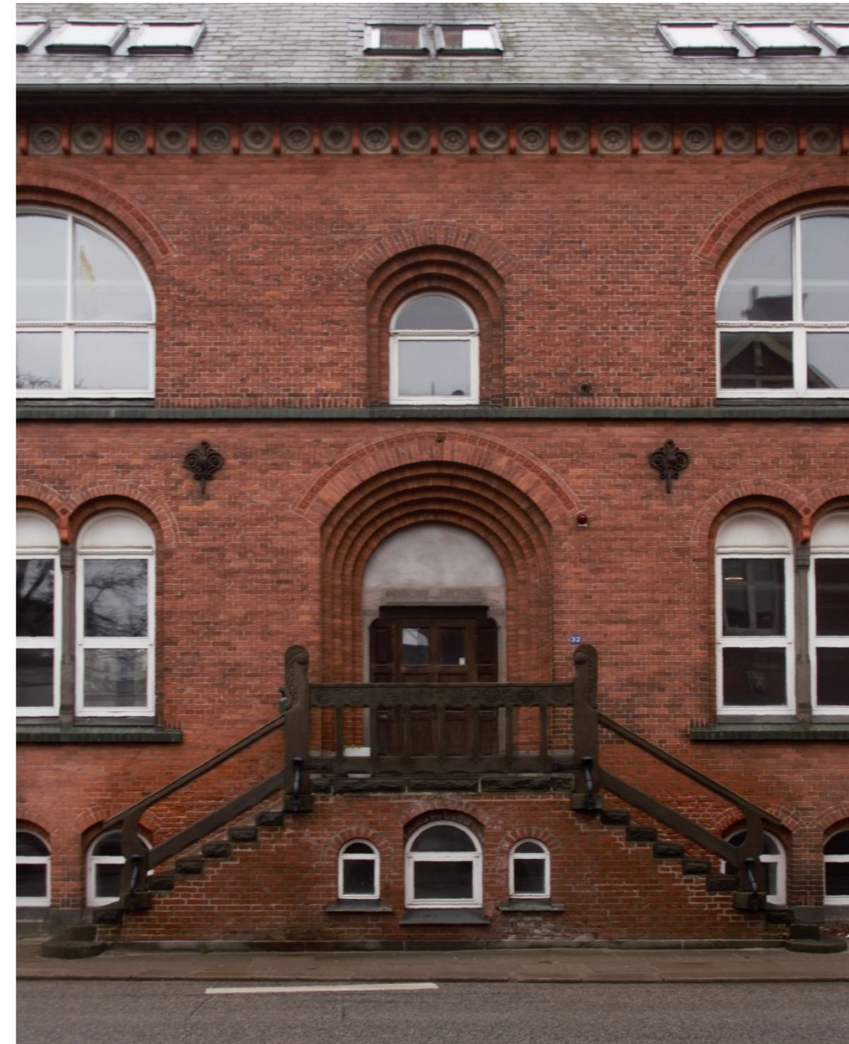
B. Registreringsfoto, Hjørring Teknisk Skole, Østlig facade
