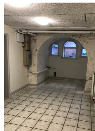
Kælderrum under hovedtrappe
