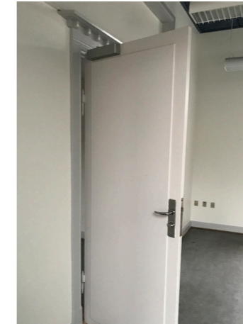
Plademateriale som brandsikring af dører
