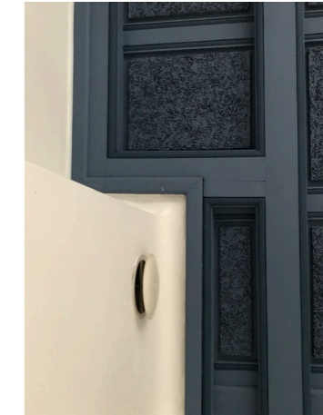
Troldekt plader i forhusets loft
