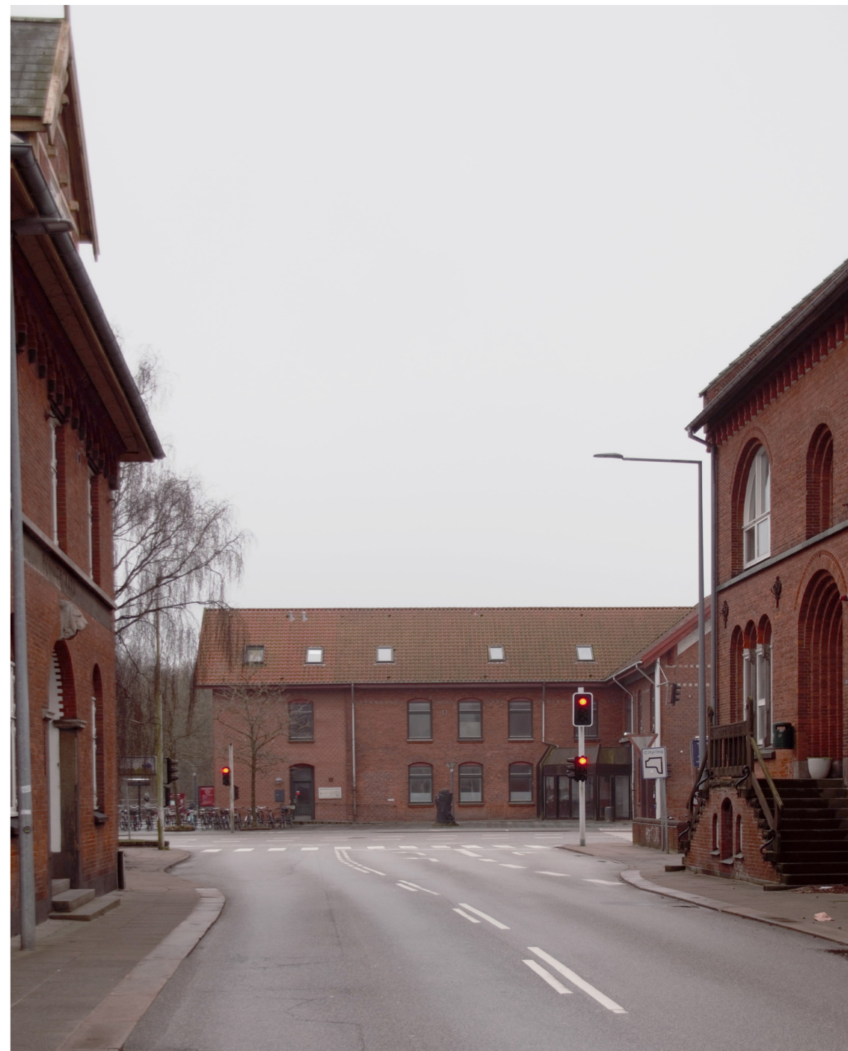
Sparekassens Vestlige facade
