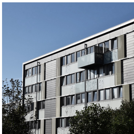
Facade efter renovering i 2010
