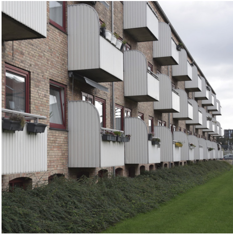
Repetitiv facade med stålaltaner
