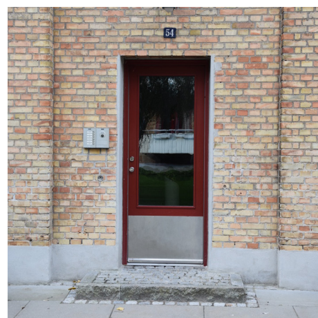
Hoveddør til opgang, efter renovering
