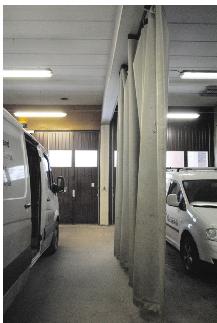
Här ses den bärande konstruktionen av pelare och bjälkar i garagedelen
