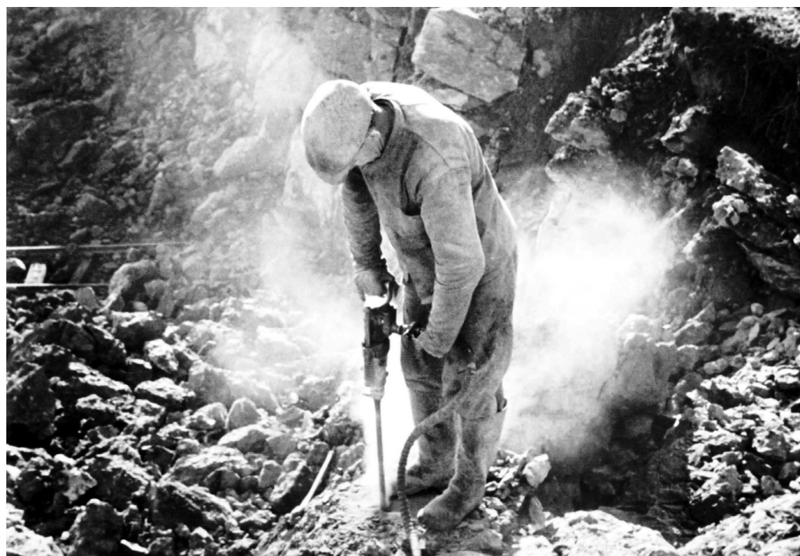
Figur 13 - Boring for kalkstein Foto: Cementmuseet, Slemmestad
