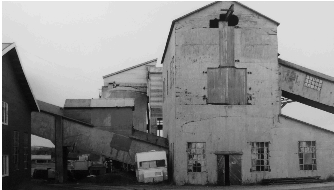
Figur 40 - Industribygg Foto: NJM - fotosamling
