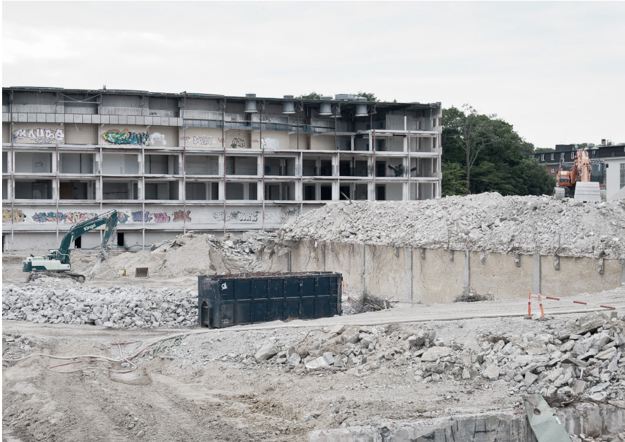
Nedrivning af lagerbygninger på Carlsberg
