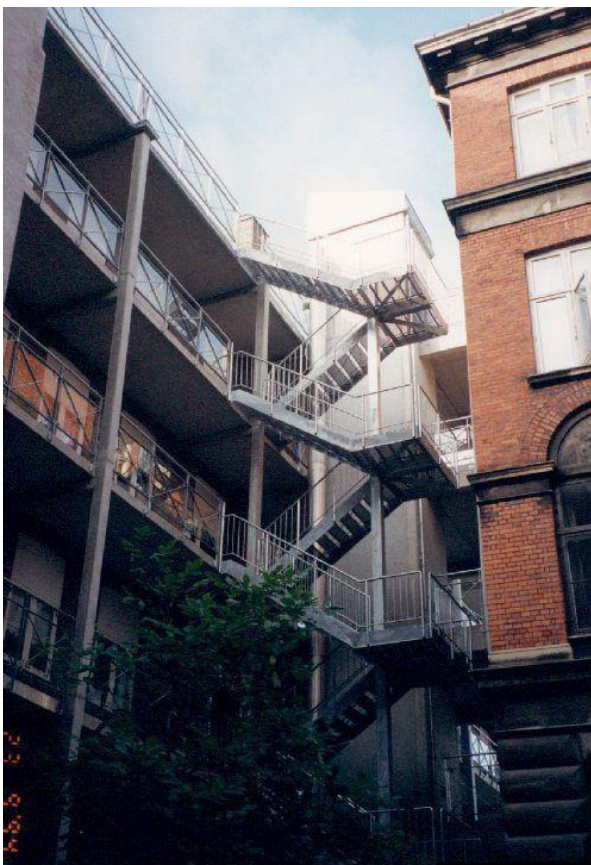
Ill. 30. Brandtrappe forbinder bygning 2 med privatbyggeri 1994
