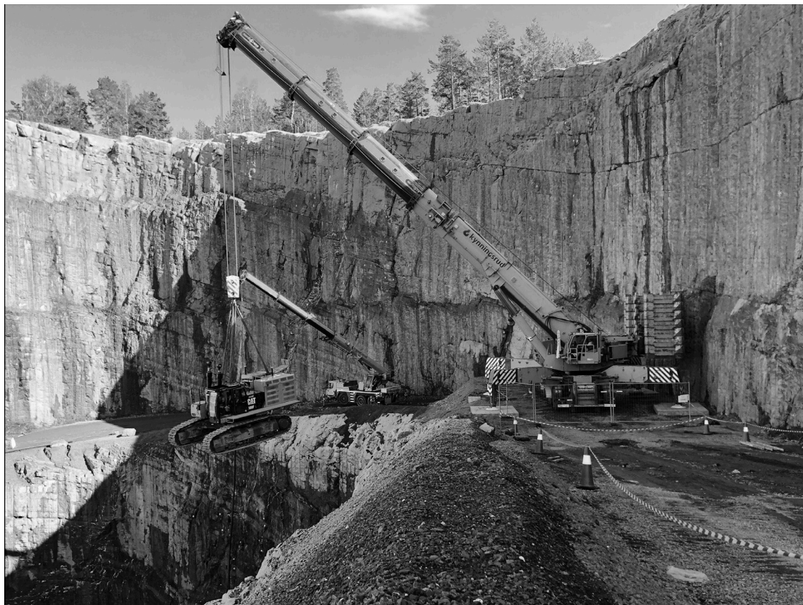
Figur 36 - Maskinløft i Sydbruddet Foto: NOAH
