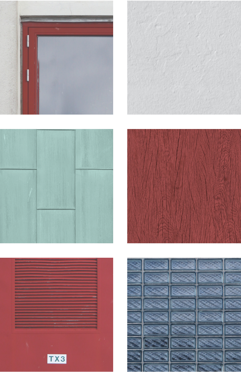
Hvid puds, kobber, malet fyrretræ, rødmalede jerndøre, glas-bygningssten, beton, røde mursten
