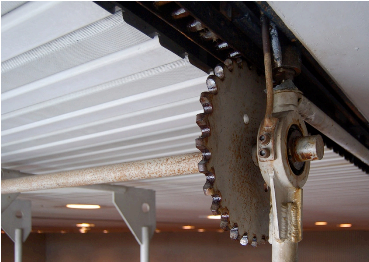
Skydebroerne, under hallens loft, bevæges med håndsving.
